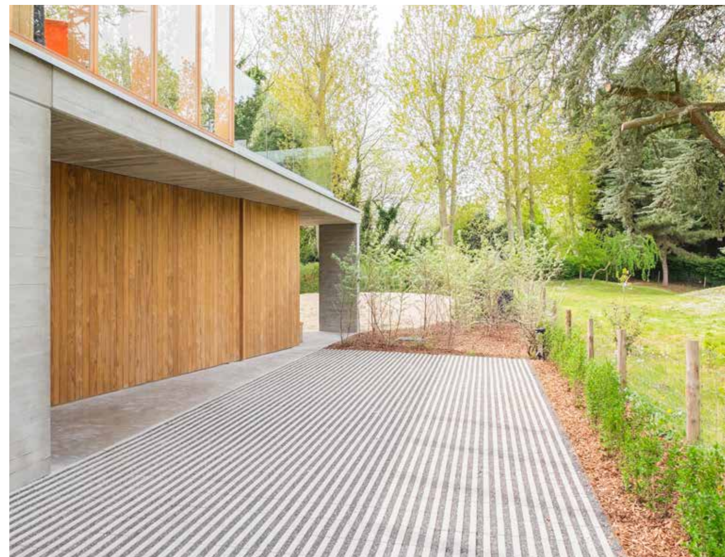
Inrit met Grasslines Small, met voegvulling van grijze kiezel
