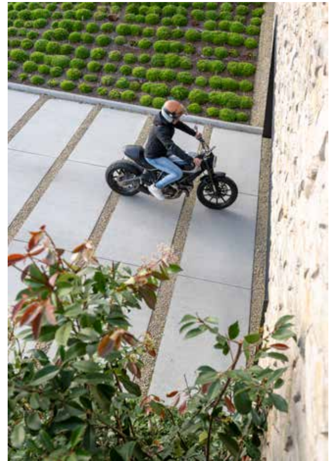
Eurodal Residential vloerplaten gelegd met open voegen die meer dan 10% van de totaaloppervlakte vormen, gelden ook als een waterpasserende verharding.
